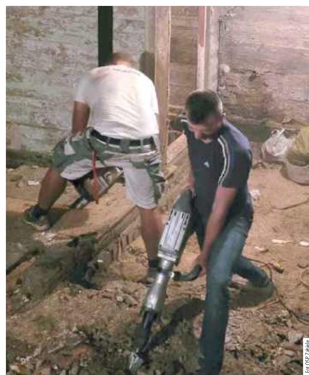
Przy demontażu podłogi pracują fachowcy z lokalnych firm budowlanych
