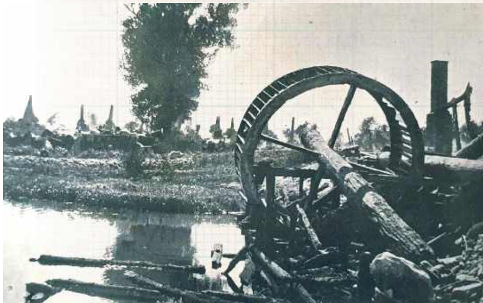
Spalony most i zabudowania w miejscowości Serokomla (dziś pogranicze powiatów łukowskiego i lubartowskiego). Rosjanie, wycofując się, stosowali taktykę spalonej ziemi - niszczyli budynki, zapasy oraz mosty. Miało to na celu opóźnienie pochodu wojsk Państw Centralnych. Zdjęcie z „Albumu I Pułku I Brygady Legionów Polskich 1915” (Drukarnia Narodowa w Krakowie, 1915 r.)
