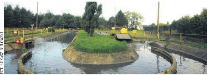
Stara przepływowa oczyszczalnia ścieków w Alwerni. Takich obiektów już się nie buduje i raczej nie modernizuje
