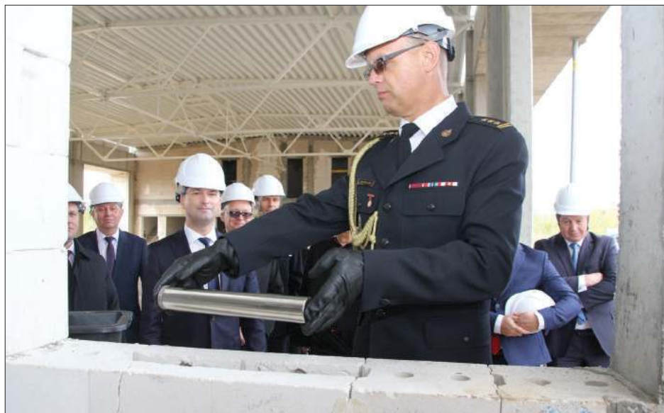
➤ Metalową tubę z umieszczonym w niej aktem erekcyjnym, w otworze jednej ze ścian budynku umieścił st. bryg. Leszek Niewęgłowski, komendant KP PSP w Rykach
