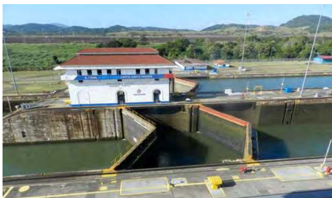
Śluzy na kanale podnoszą statki na wysokość 26 m.
