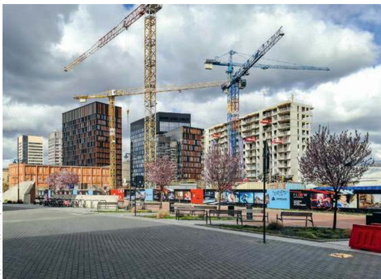
Budowa mieszkań deweloperskich w Łodzi. Kwiecień 2025 r.
