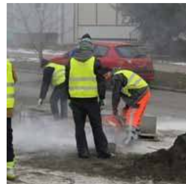
Ekipy remontowe wyruszyły na ulice, aby łątać dziury, które powstały podczas zimy
