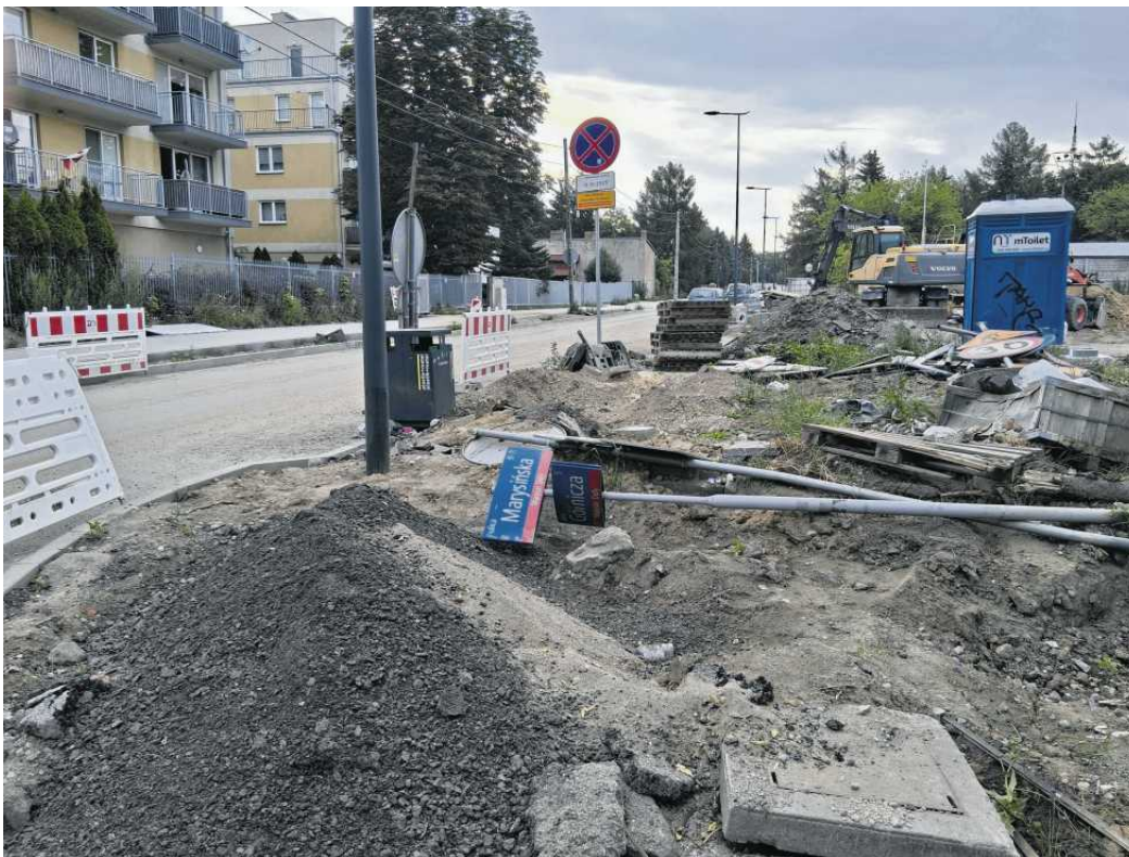
• Remont ulicy Marysińskiej
