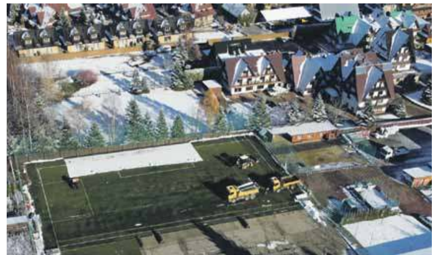
Trwa rozbiórka boiska na Pardałowce w Zakopanem.
