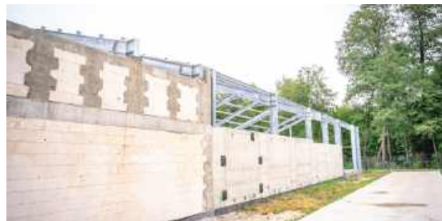
Wkrótce rozpoczną się prace wewnętrzne
