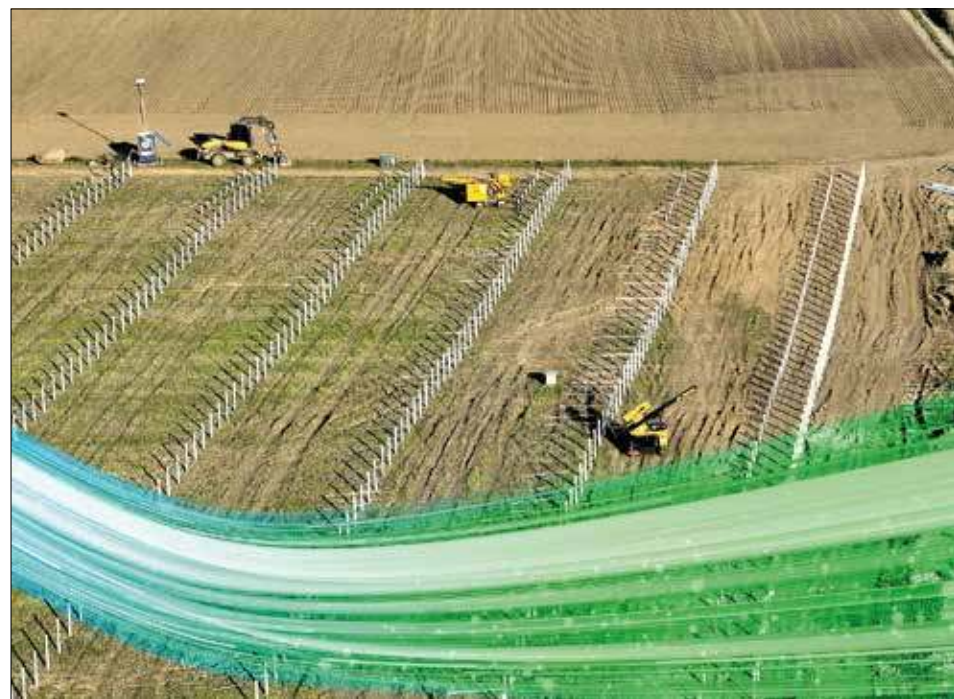
Budowa farmy fotowoltaicznej Dygowo I
