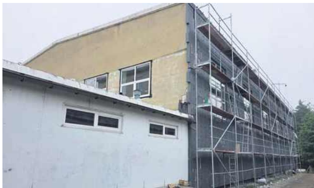
Trwa kompleksowa modernizacja II LO
