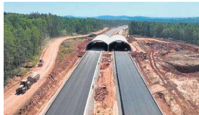
Trwa budowa drogi ekspresowej S74 Mniów - Kielce. Ogólne zaawansowanie prac przekroczyło 65 procent
