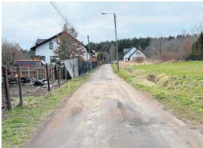
Zmodernizowana zostanie między innymi starachowicka ulica Jezynowa.
