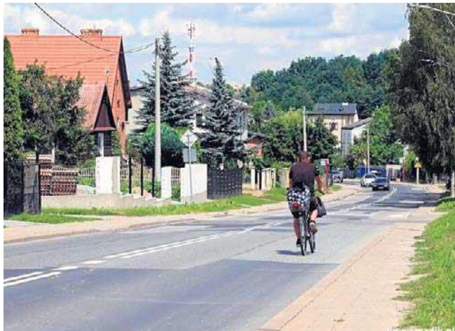
Nowe drogi dla rowerów i ciągi pieszo-rowerowe powstaną przy ulicy Witkacego w Radomiu.
