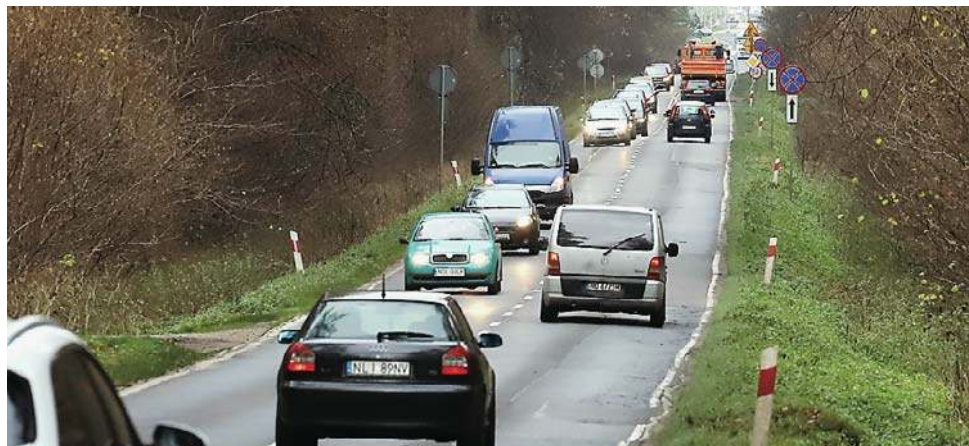
Budowa obwodnicy Olsztyna i Dywit zakładała przebudowę drogi 51 przez Las Miejski
