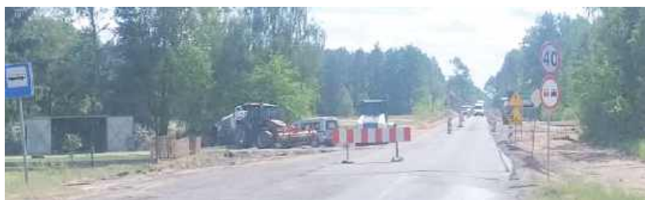
W rejonie Sosnowicy ruchem steruje sygnalizacja świetlna, obowiązuje też ograniczenie prędkości
