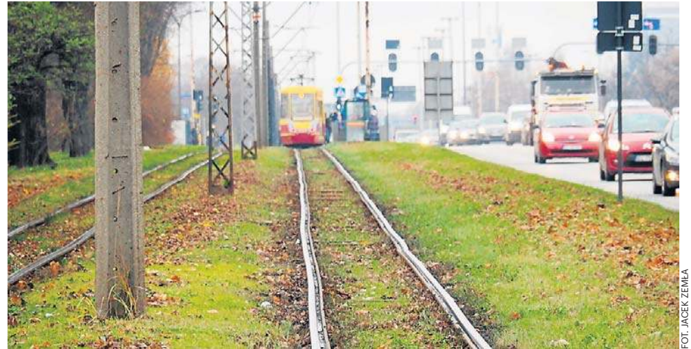
Oprócz remontów licznych ulic Teofilów doczeka się także niebawem modernizacji linii tramwajowej na ul. Aleksandrowskiej
