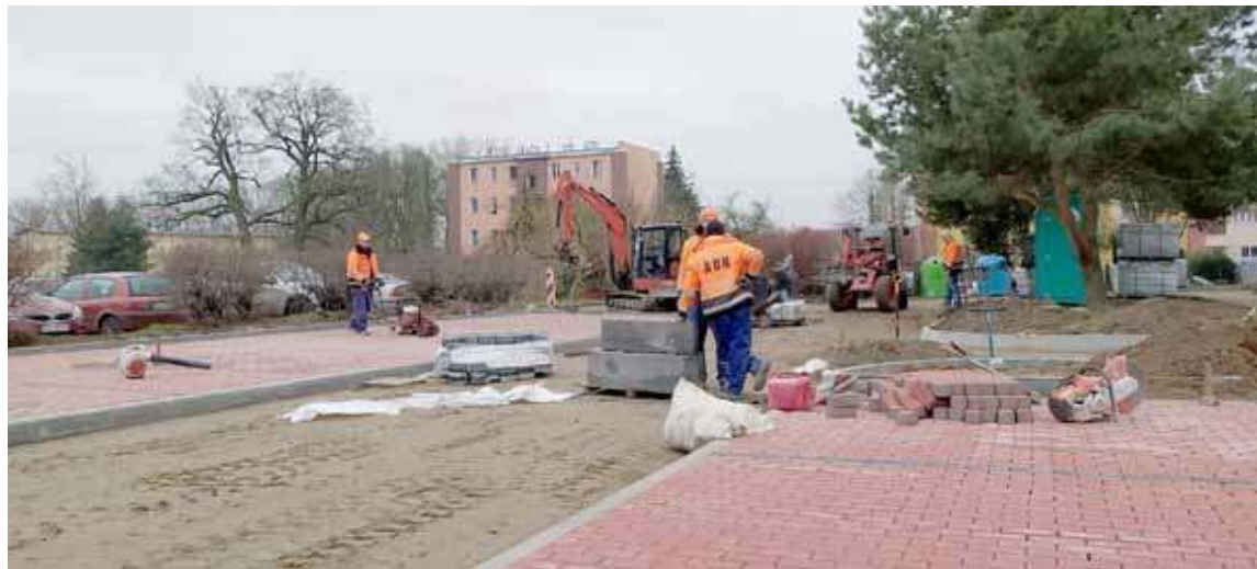
Miejsca postojowe za blokami już właściwie gotowe
