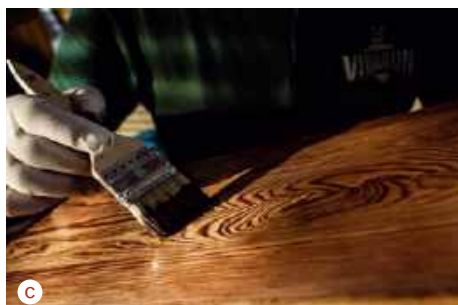
🔧 Kolejne etapy renowacji drzwi. Usuwanie starej powłoki za pomocą papieru ściernego (a SADOLIN), nanoszenie wosku (b TIKKURILA), lakierobejcy (c VIDARON), farby kryjącej (d ŚNIEŻKA).
