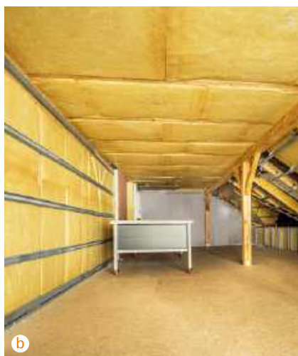
🔧 Styropian na ściany (a AUSTROTHERM) i wełna mineralna na poddaszu (b ISOVER) – tak przeważnie ocieplamy domy.
