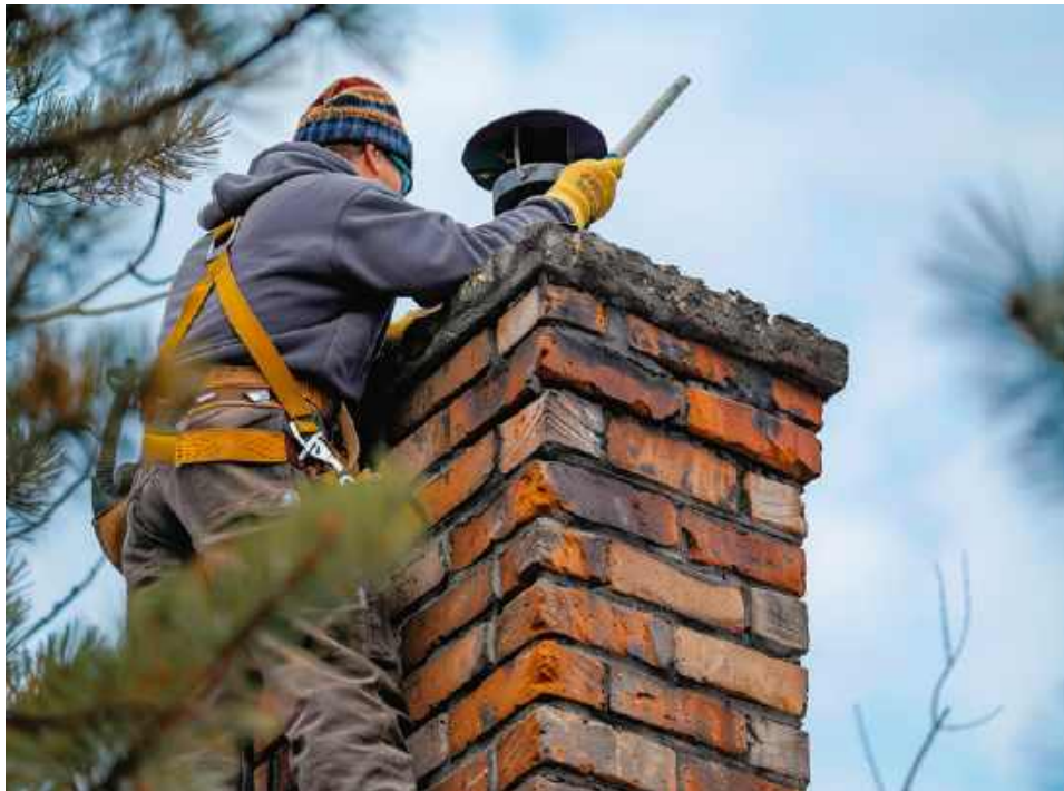
❶ Raz do roku właściciel domu powinien zlecić mistrzowi kominiarskiemu sprawdzenie stanu komin. ADOBE STOCK
