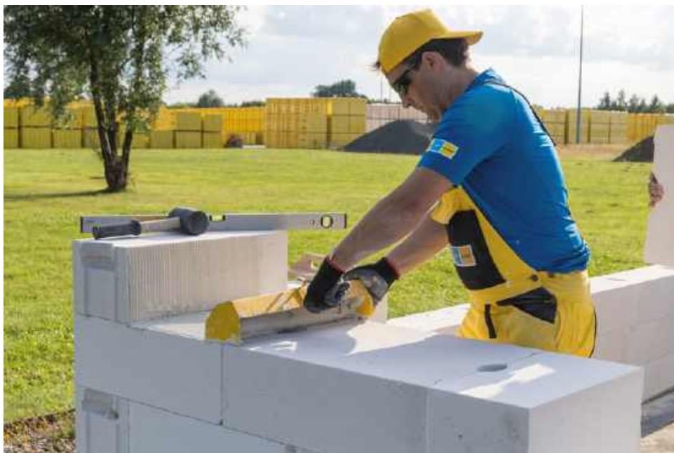
🔧 Murowanie na ciekłą spoinę jest dość wymagające, ale pozwala uzyskać ścianę jednorodną pod względem termicznym i dobrze izolującą przed stratami ciepła. YTONG (XELLA)
