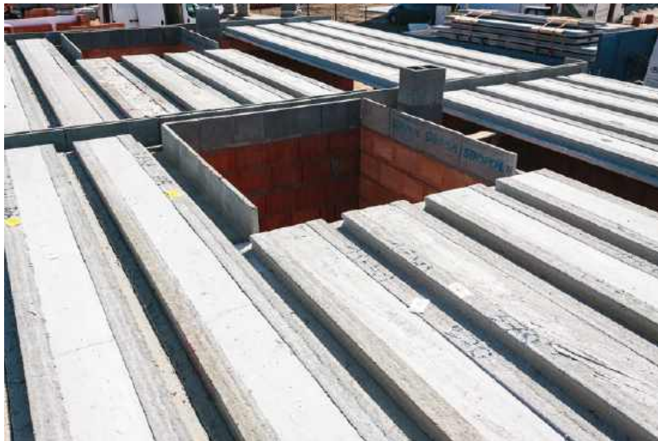
🔴 Panele stropowe mogą mieć różną długość. W fabryce przygotowuje się je pod konkretny projekt, dowozi na miejsce budowy i montuje za pomocą dźwigu HDS. Przeważnie ich ułożenie nie trwa dłużej niż dwie godziny. STROPY.PL
