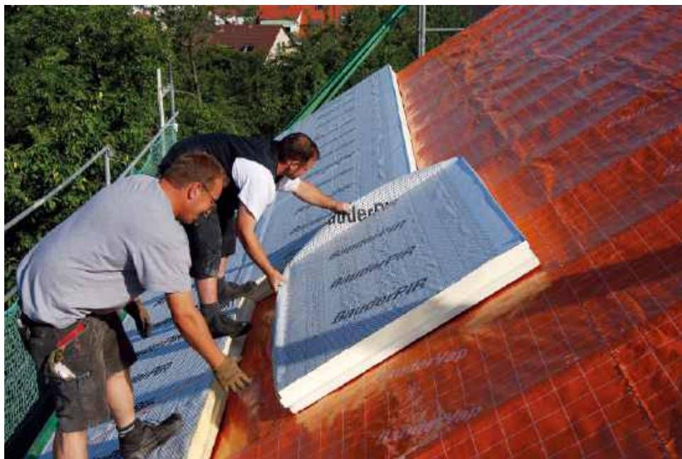
🔧 Termoizolacja z płyt z piany PIR mocowanych nakrokwiowo. BAUDER
