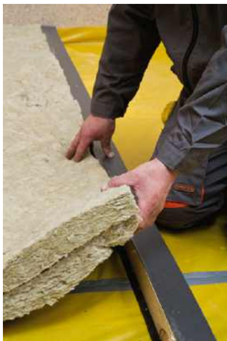
🔧 Układanie izolacji z wełny mineralnej pomiędzy belkami. WOODECO
