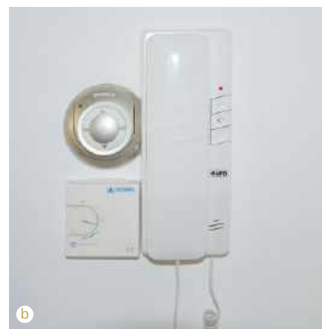
🔔 Bramofon najczęściej montuje się na słupku przy furtce (a ELFON), a unifon w budynku przy drzwiach wejściowych (b L. JAMPOLSKA).
