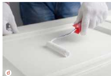
🔧 Kolejne etapy renowacji drzwi. Usuwanie starej powłoki za pomocą papieru ściernego (a SADOLIN), nanoszenie wosku (b TIKKURILA), lakierobejcy (c VIDARON), farby kryjącej (d ŚNIEŻKA).
