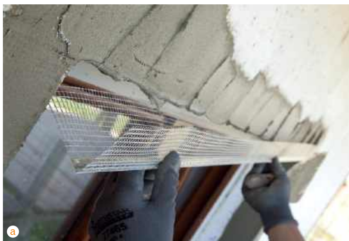
🔪 Narożnik aluminiowy z siatką (a), listwa startowa (b) – metoda lekka mokra to nie tylko tynk i ocieplenie. ARCHIWUM BD
