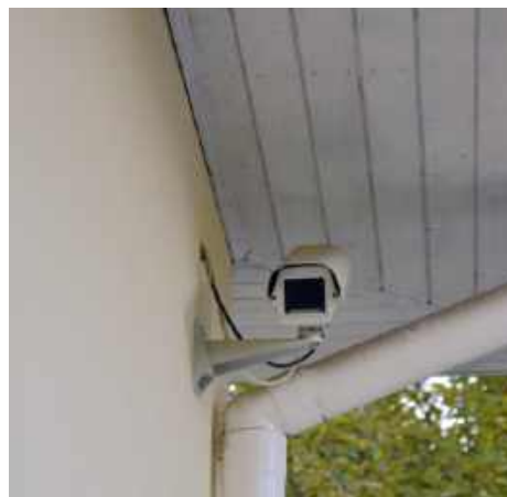
Kamery na ogół mają szerokie pole widzenia i siłownik do jej obracania. L. JAMPOLSKA
