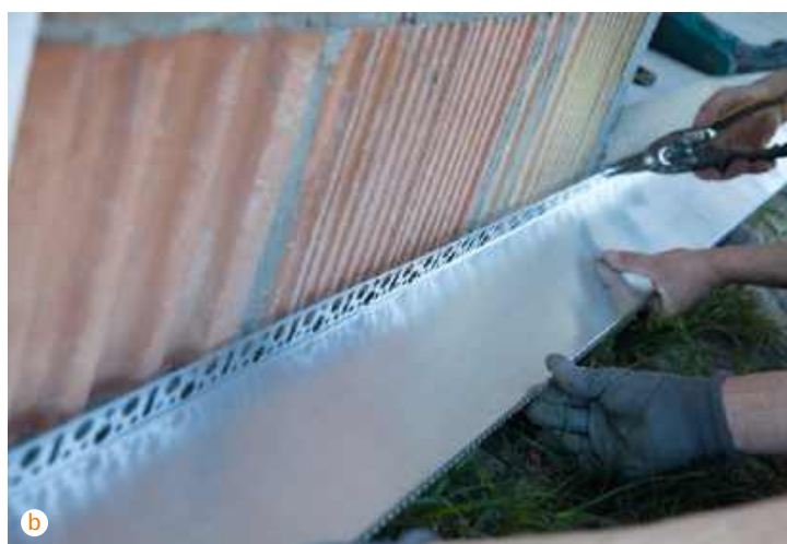
🔪 Narożnik aluminiowy z siatką (a), listwa startowa (b) – metoda lekka mokra to nie tylko tynk i ocieplenie. ARCHIWUM BD
