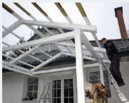
🔧 Na dachu zamontowano nowe tały i płyty z poliwęglanu.
