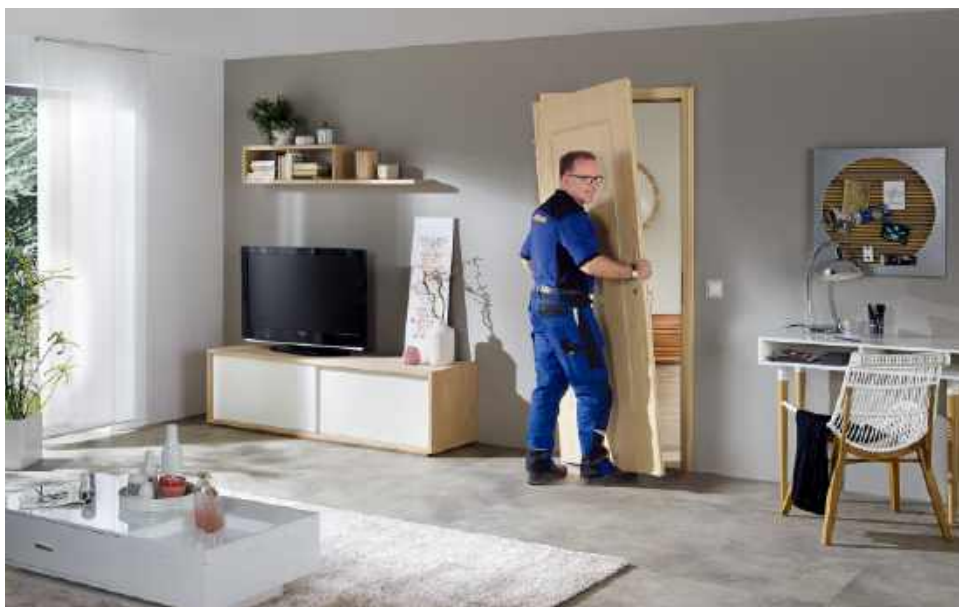
🔧 Ostatnim etapem wymiany drzwi jest osadzenie skrzydła na zawiasach. HÖRMANN
