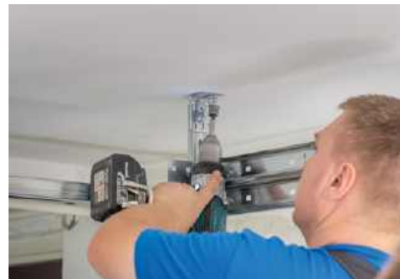
🔧 Kołki, za pomocą których przytwierdza się ościeżnicę i prowadnice bramy, muszą być dopasowane do rodzaju materiału, z jakiego wykonane są przegrody. NOVOFERM
