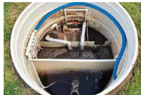
🔧 Oczyszczalnie kompaktowe zajmują niewiele miejsca, bo oczyszczanie odbywa się w szczelnych zbiornikach.
