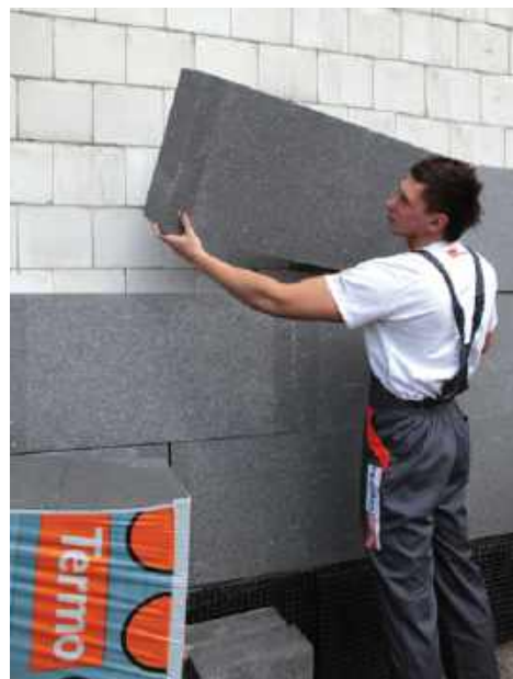
🔧 Płyty izolacyjne muszą być dobrze spasowane. W przeciwnym razie na ich obwodach mogą powstać mostki cieplne. TERMO ORGANIKA
