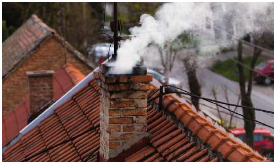
🔥 Bez ważnego przeglądu kominiańskiego nie będzie odszkodowania za szkody wywołane pożarem – nawet, gdy dom był ubezpieczony. FOTOLIA
