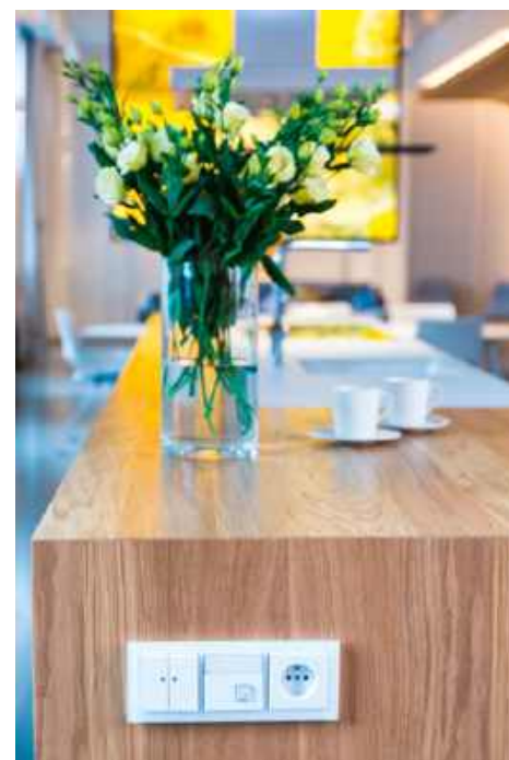
🔧 Gniazda oraz inny osprzęt można zakładać również w nietypowych miejscach, np. z boku blatu-wyspy w kuchni. ABB
