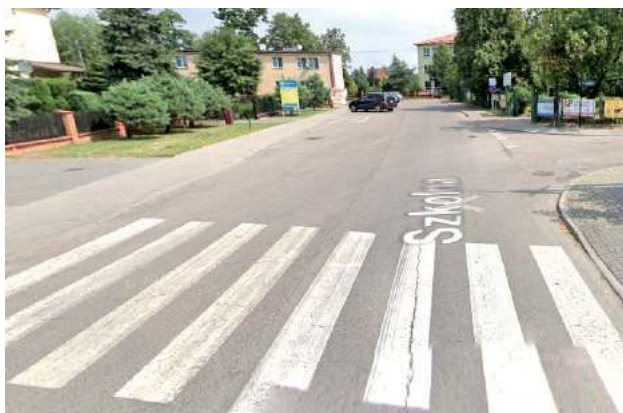
Jest szansa, że ul. Szkolna zostanie wyremontowana
