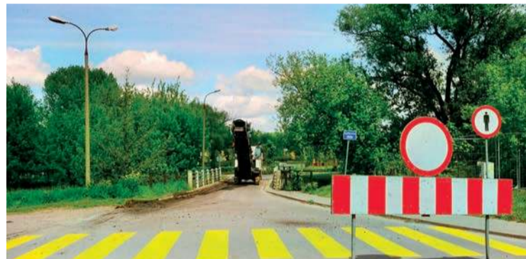
Most na Łydyni przy ulicy Augustiańskiej
