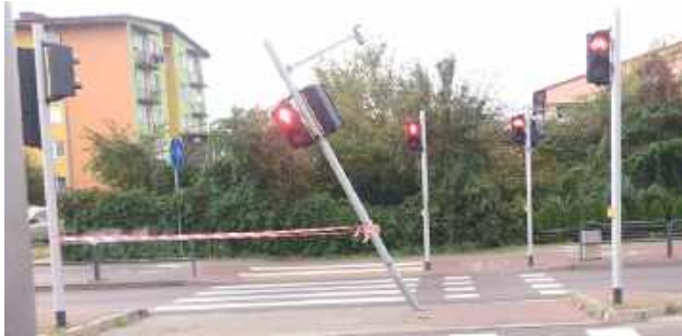
Tak „zabezpieczony” uszkodzony sygnalizator stał w Biłgoraju przy al. Jana Pawła II przez kilku tygodni
