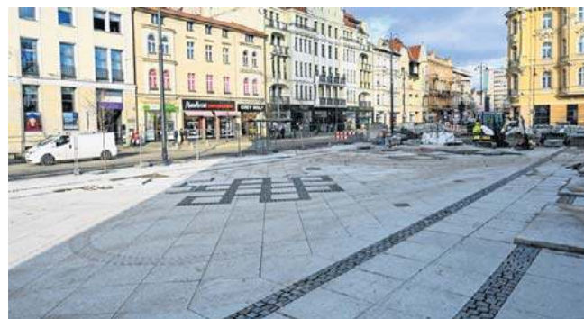
Tak sytuacja na placu budowy wyglądała w listopadzie
