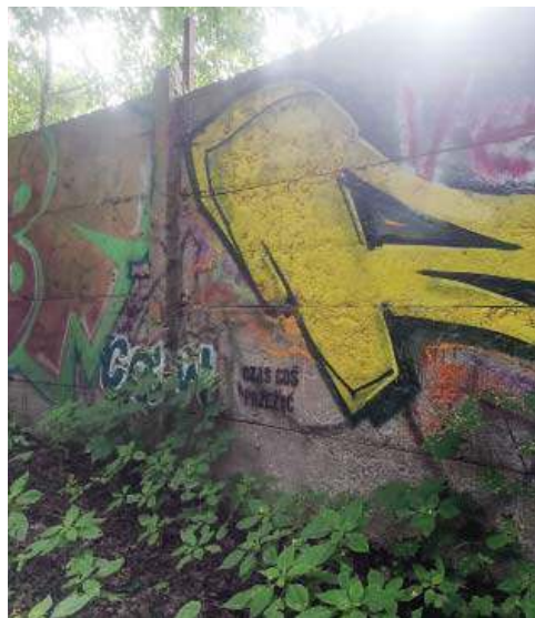
Betonowy płot przy „Łynostradzie”. Las Miejski
