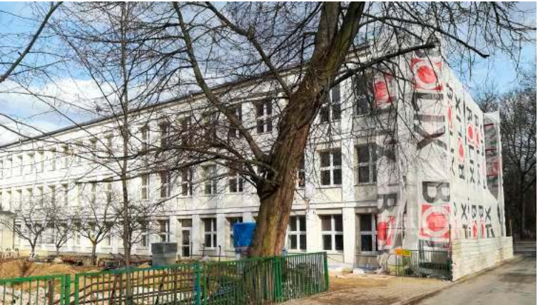
Termomodernizacja SP nr 18 z początkiem roku ruszyła pełną parą
