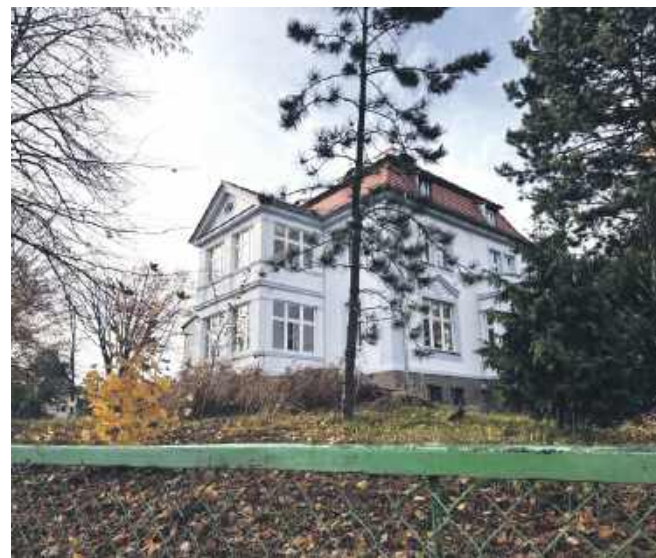
Część elewacji czwartej ściany już odnowiono
