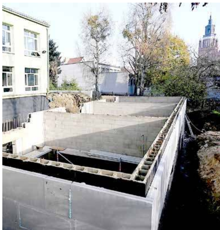
Plac rozbudowy Przedszkola Miejskiego nr 2
