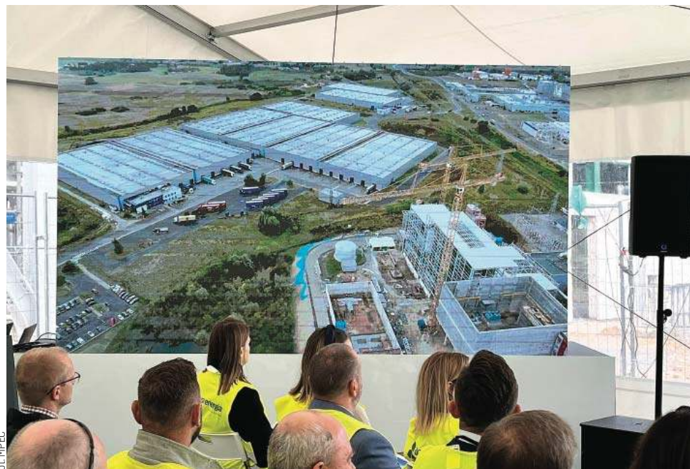
Olsztyn buduje nową miejską ciepłownię, która ma być opalana paliwem alternatywnym. Inwestycja ma być gotowa w przyszłym roku
