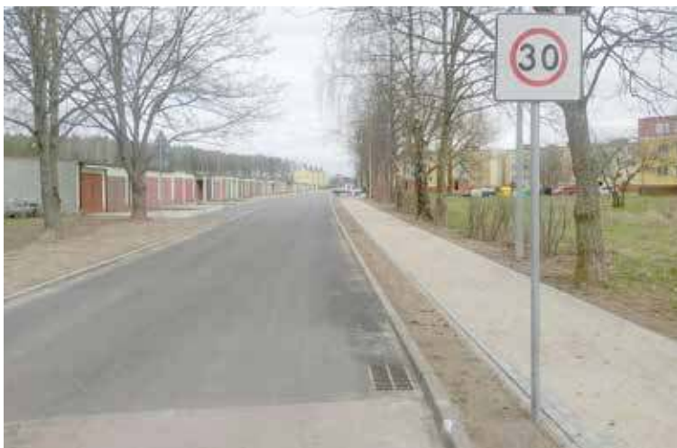
W przypadku braku uregulowania opłaty za wykonanie odcinka drogi na ul. Leśnej, PRD miało twarde argumenty, aby nawet iść do Sądu o wyegzekwowanie należności
