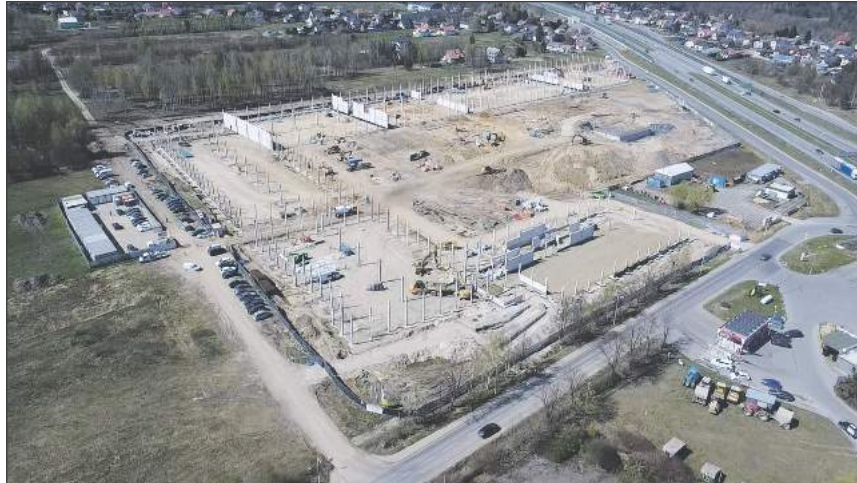
■ Stan budowy Świderek Park na koniec kwietnia (fot. materiały inwestora)
