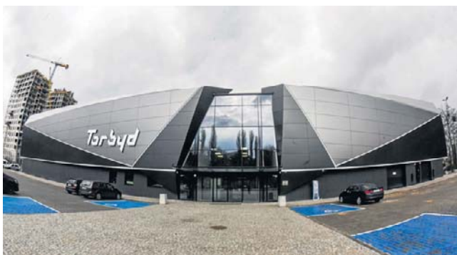
Na „Torbydzie” zostanie zamontowanych 335 modułów
