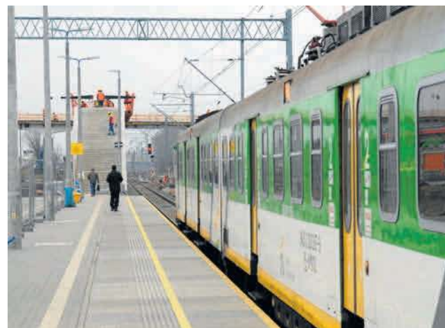
W wielu miejscach na trasie numer osiem trwają prace modernizacyjne bez ograniczania kursowania pociągów.
