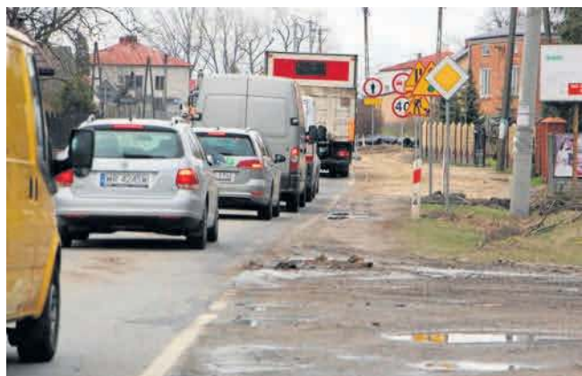
Jeden z odcinków przebudowywanej drogi wojewódzkiej numer 740 przebiega przez Wrzeszczów w gminie Przytyk.
