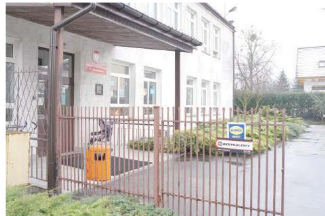
Jednym z budynków, który w pierwszej kolejności ma przejść termomodernizację jest przedszkole w Końskowoli
