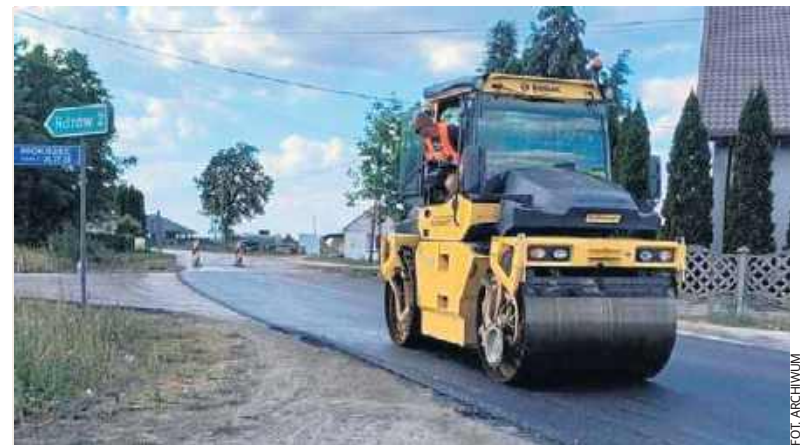
Po zakończonej inwestycji kierowcy będą mieli równą drogę, a to poprawi bezpieczeństwo przejazdu.
