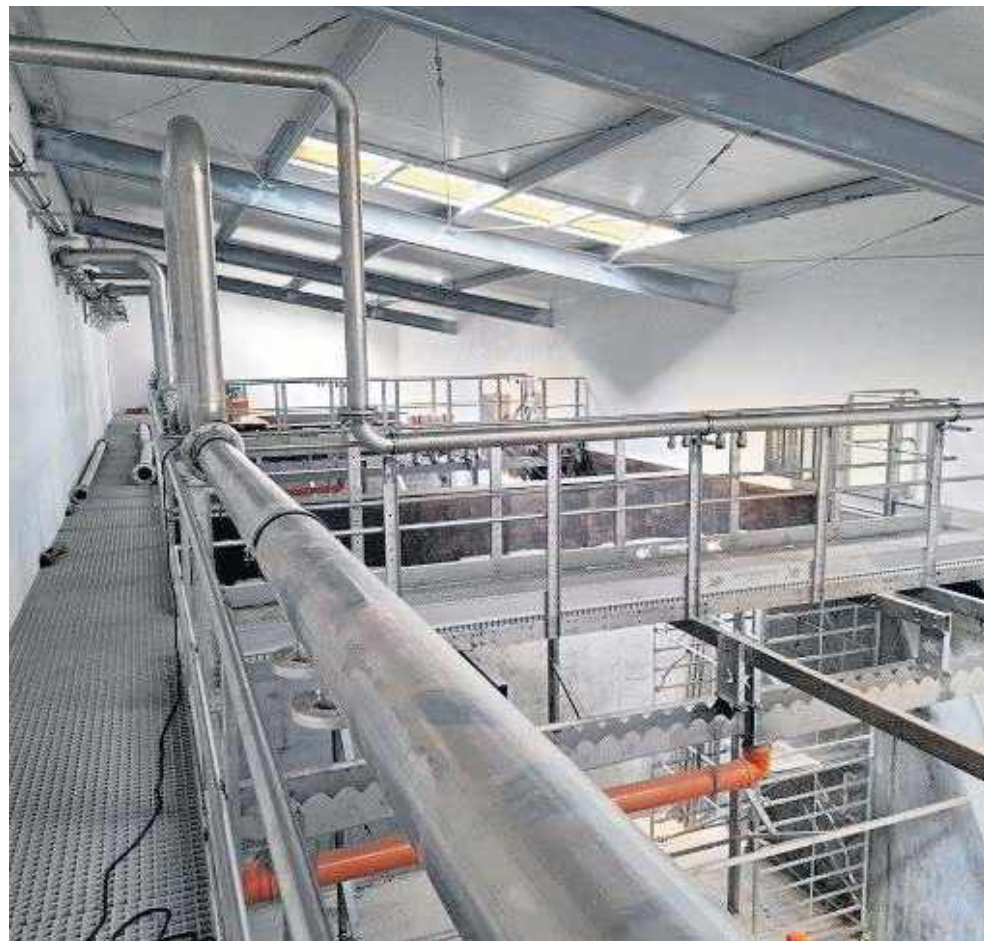
W ramach inwestycji powstają nowe reaktory biologiczne.
