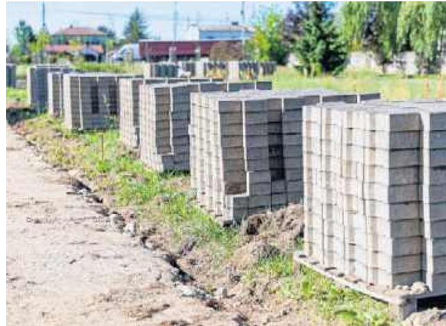
Na skwerku w Goździe rozpoczęły się prace związane z budową nowoczesnego terenu rekreacyjnego.
