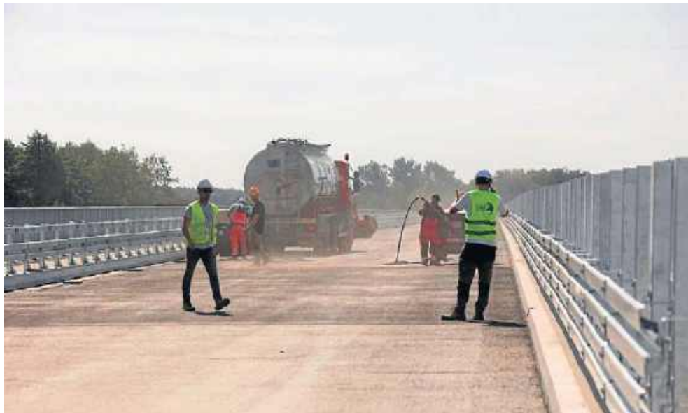
Na jednej z estakad obwodnicy Morawicy i Woli Morawickiej trwają ostatnie prace
