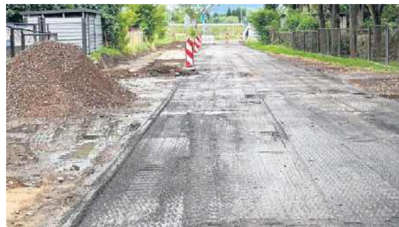
Rozpoczęła się przebudowa ulicy Sadkowskiej przy Publicznej Szkole Podstawowej numer 27 i Zespole Szkół Elektronicznych.
