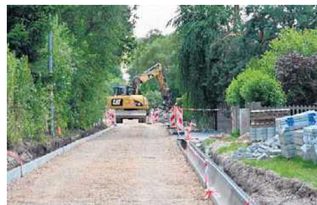
Ulica Wspólna zyska nowe odwodnienie i nawierzchnię, co poprawi komfort oraz bezpieczeństwo użytkowników drogi
