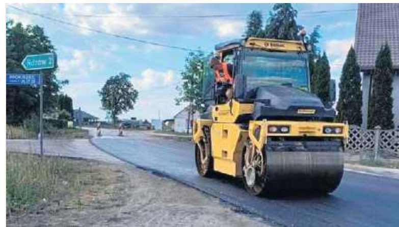
Po zakończonej inwestycji kierowcy będą mieli równą drogę, a to poprawi bezpieczeństwo przejazdu.
