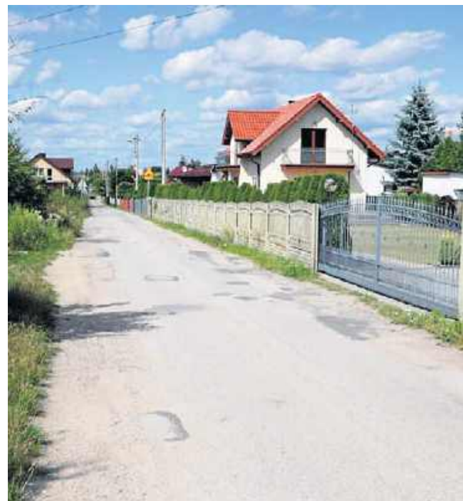
Najdłuższy remont zaplanowano na ulicy Białogońskiej. Drogowcy zajmą się odcinkiem liczącym około 680 metrów
