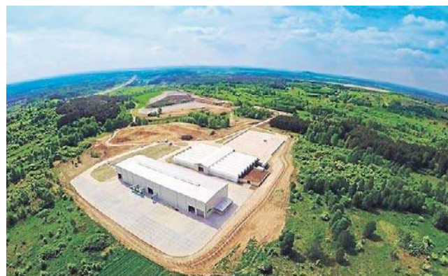
Wielka inwestycja na terenie składowiska odpadów w Balinie. Powstanie tam centrum recyklingu
