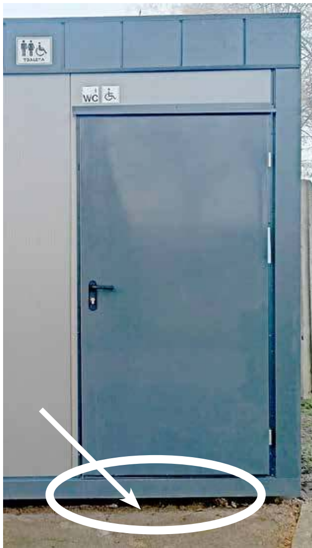
Kontener toaletowy zainstalowany w ubiegłym tygodniu przy głównym wejściu na nowogardzki cmentarz. Strzałka pokazuje próg nie do pokonania wózkiem inwalidzkim
