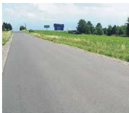
Droga w Obrowie po remoncie.
