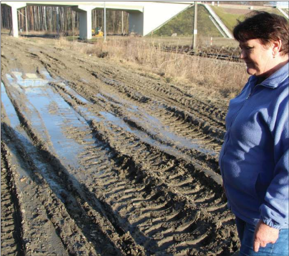
Elżbieta Wawer, by dostać się do stacji kolejowej, musi za każdym razem pokonywać błotnistą drogę
