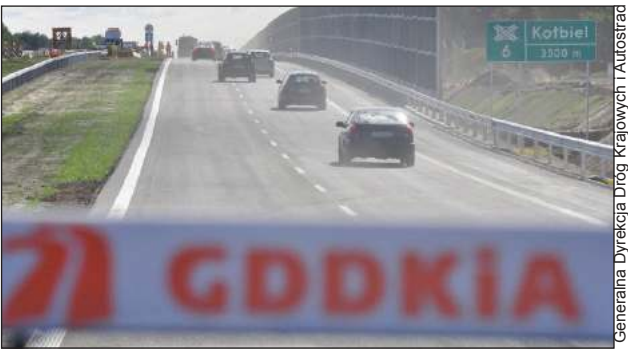
W środę, 10 marca WINB w Warszawie wydał pozwolenie na użytkowanie dwóch odcinków S-17: od węzła Lubelska do obwodnicy Kołbieli (ok. 15,2 km) oraz obwodnicy Kołbieli (ok. 8,7 km)
