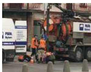
Na większości odcinków wy- korzystano technologie bezwy- kopowe. Dzięki temu możliwe było odnowienie istniejących kanałów bez konieczności wy- konywania rozległych wykopów.
