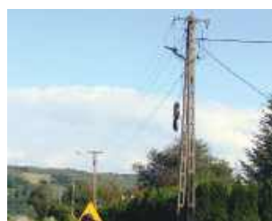
W ramach inwestycji wymieniono 358 starych opraw sodowych na energooszczędne lampy LED.
