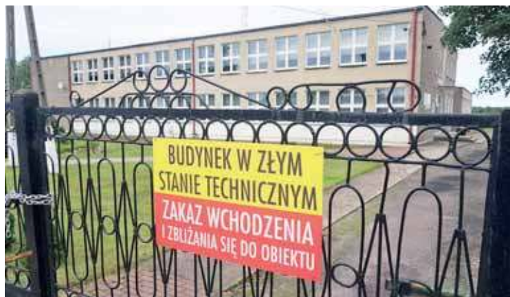
W związku ze złym stanem technicznym, budynek szkoły został zamknięty na podstawie wyników pokontrolnych.
