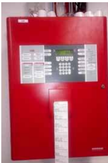
W szpitalu sprawdzono stan techniczny wszystkich systemów pożarowych połączonych z centralą sygnalizacji pożaru
