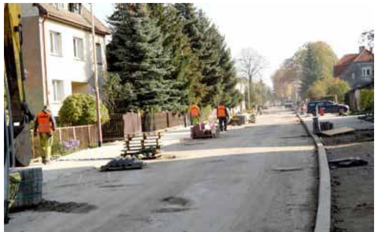
Pod koniec czerwca rozpoczęły się prace związane z przebudową ul. Wojska Polskiego
