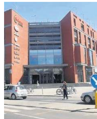
W tym miejscu powstanie sygnalizacja świetlna.
