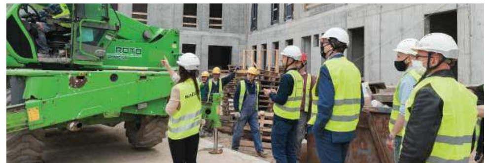
Planowany termin zakończenia inwestycji to 30 czerwca 2023 roku, ale być może uda się oddać obiekt wcześniej, bo prace są bardzo zaawansowane
