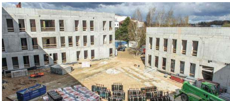
Do tej pory na budowie zużyto ponad 7,5 tys. m 3 betonu i 650 ton stali
