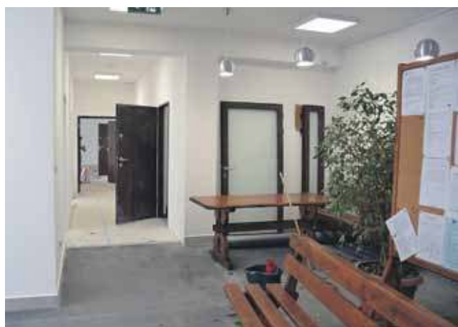
Budynek gminy w Szaflarach w trakcie remontu.
