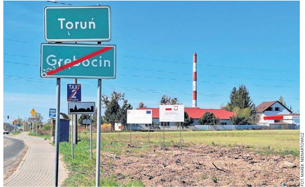
Przebudowa 2-kilometrowego odcinka ulicy Olsztyńskiej - stan na wtorek 28 kwietnia
