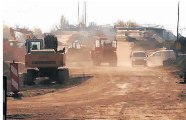
Trwają roboty przy przebudowie ulicy Wojska Polskiego w Radomiu. Drogowcy zrealizowali już dwa etapy inwestycji.
