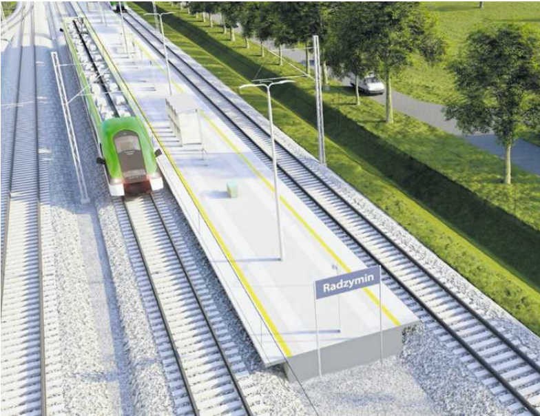
• Stacja PKP Radzymin na linii kolejowej nr 10 Legionowo - Tłuszcz po remoncie FOT. MATERIAŁY PLK
