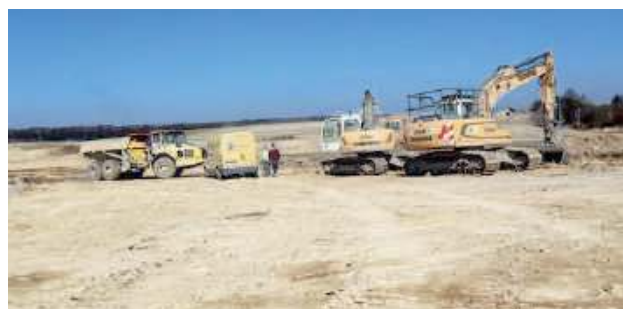
Obecnie prowadzone są roboty rozbiórkowe i ziemne
