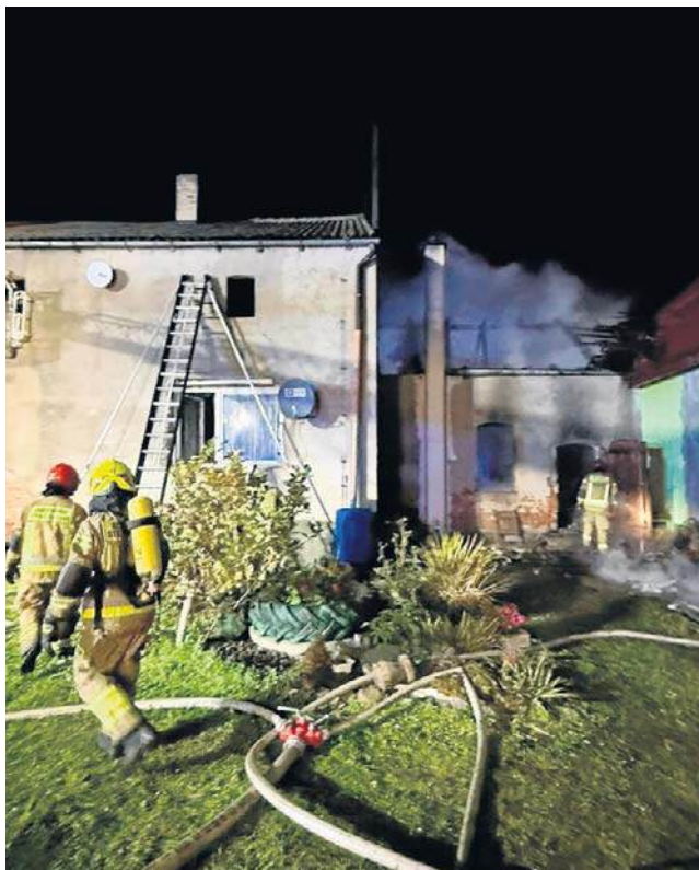
Pożar budynku wielorodzinnego w Ludwikowie. Spalił się budynek kotłowni wraz z więźbą dachową.
