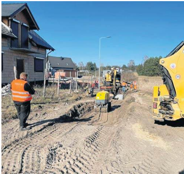
Zakończyła się budowa kanalizacji sanitarnej w Sławie Wielkopolskiej
