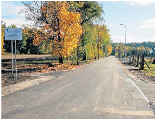
Droga w Łosińcu oddana do użytku po przebudowie.
