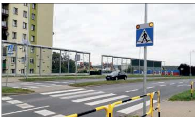
W ramach tegorocznego budżetu obywatelskiego przy ul. 26 Marca zamontowane zostały dwa znaki aktywne z pulsatorami LED oraz czujnikami ruchu pieszych, zestawem sterującym z komunikacją radiową i zasilaniem solarnym.
