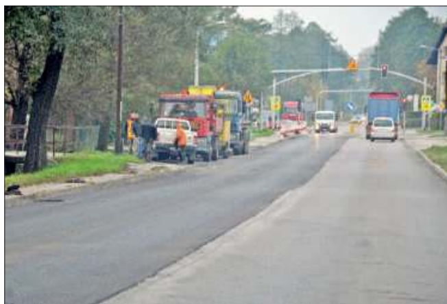
Drogowcy rozpoczęli prace 22 października
