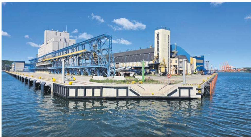
ZMPG S.A./ Nabrzeże Indyjskie po przebudowie
