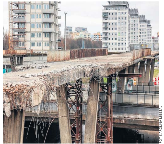
Prace na Zaspie rozpoczęły się przy końcu ubiegłego roku. Pierwszy nowy element kładki będzie oddany pieszym w okresie wakacyjnym
