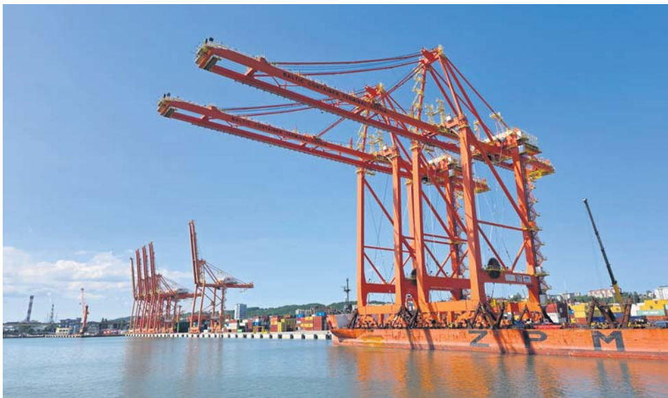
ZMPG S.A./ Nabrzeże Helskie po przebudowie
