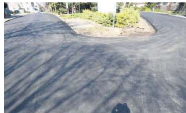
Nowy asfalt robi bardzo dobre wrażenie
