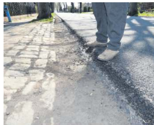
Miedzy asfaltem a najniższym miejscem w pasie obok jest kilkanaście centymetrów różnicy
