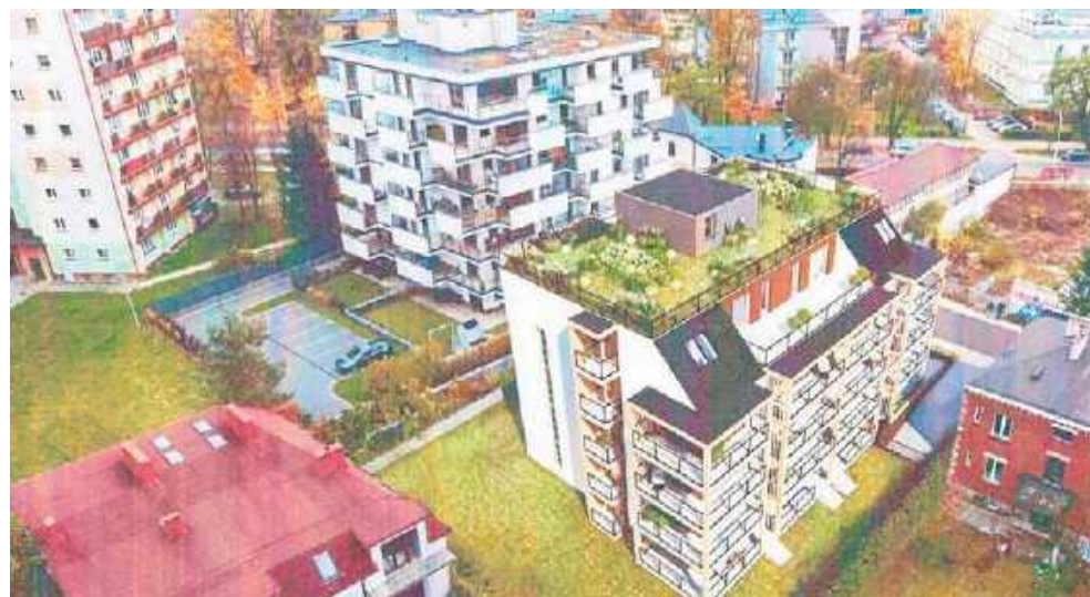
Budynek ma powstać przy ulicy Zacisze łączącej ulicę Krakowską z skwerem Szarych Szeregów w Kielcach
