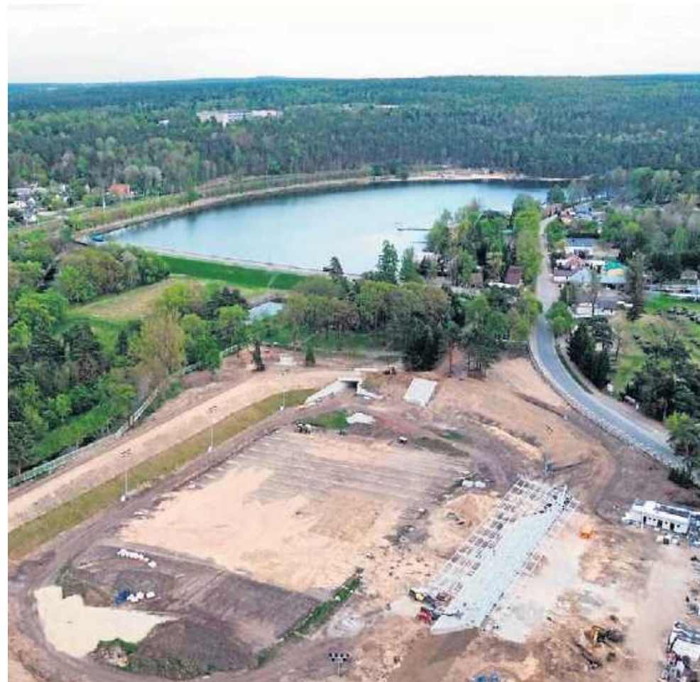
W budynku klubowym trwają prace wykończeniowe. W górę rośnie trybuna.
