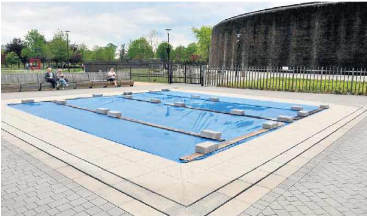
Ślady prac widać na każdym roku. Fontanna przy tętni solankowej w Busku-Zdroju jest zasłonięta
