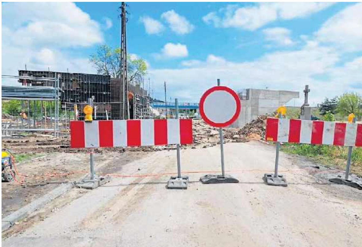
Trwa budowa nowego odcinka trasy N-S, w okolicy ulicy Gołębiowskiej jest budowany nowy wiadukt.
